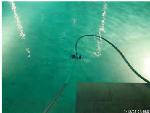
ช่างสูบล้างคอน ล้างตะไคร่สระว่ายน้ำ
